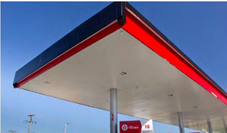
Recubrimiento prepintado por proceso continuo, lo cual confiere protección contra la corrosión. Las duelas se fabrican en color blanco o aluminio natural. Duela con diseño rectangular
