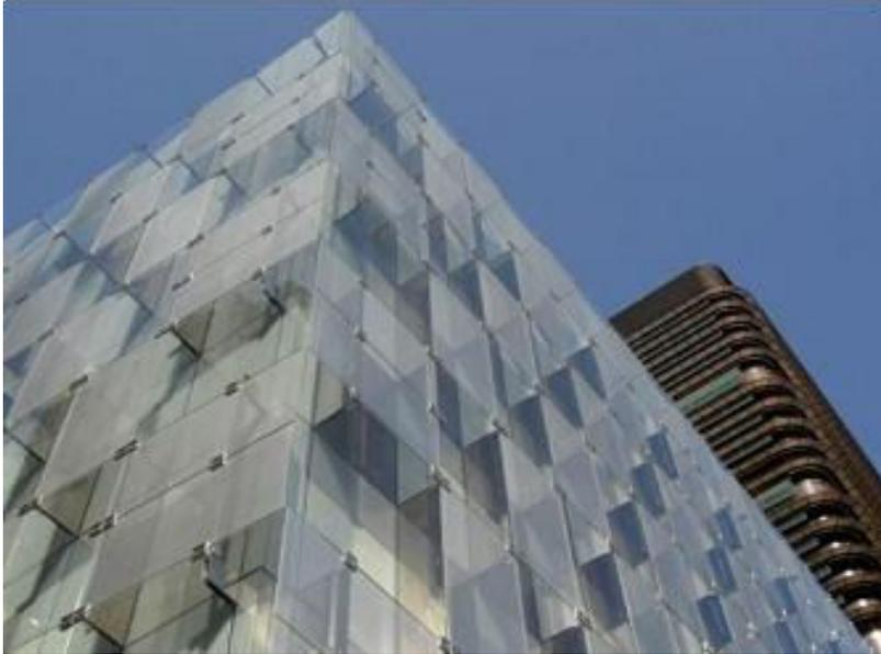
Disminuye el ruido: Cuenta con la capacidad de absorber vibraciones que causan el ruido. Este cristal es en términos generales el más eficiente ante la necesidad de disminuir el ruido causado por el tráfico, maquinaria pesada, aviones y otros muchos elementos. Esta característica hace que el vidrio laminado sea ideal en museos, aeropuertos, escuelas y edificios comerciales o residencias en zonas de alto tráfico.
